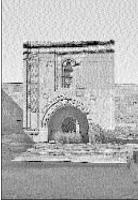
Aksaray Sultan Hanı'nın avlusundaki köşk mescid
